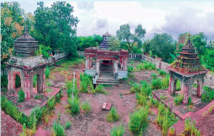
ఆంధ్రాలమ్మ ఆలయ నిర్మాణం
